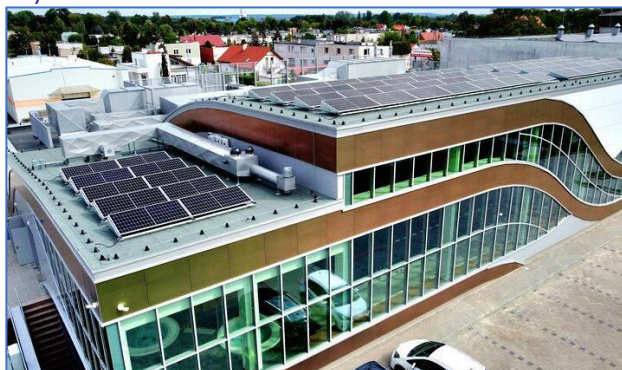
Rys. 35: Panele PV na dachu basenu w Bydgoszczy
